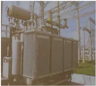
-> Trasformatore ad olio, a Torino.
